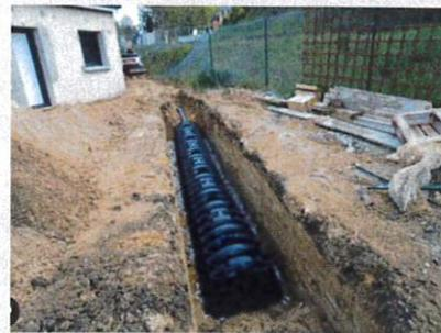
par tunnel d'infiltration
