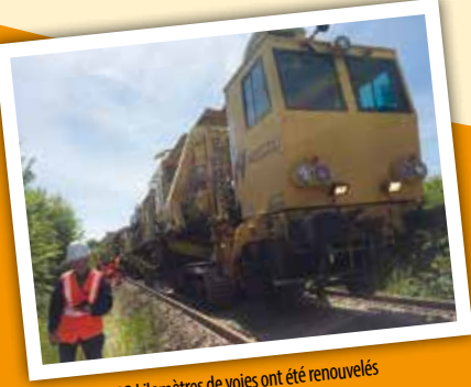
32 kilomètres de voies ont été renouvelés
